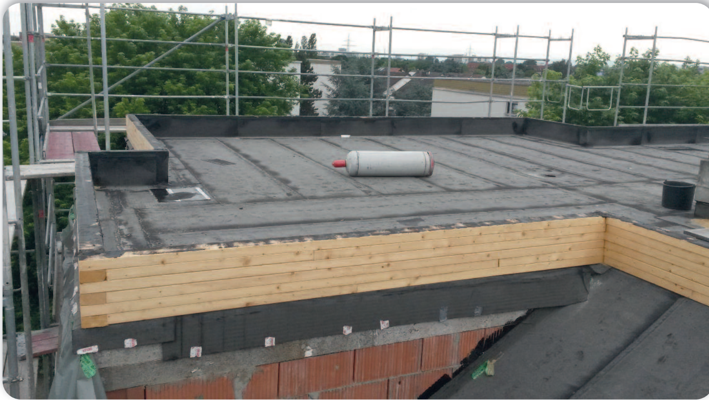
Das ambitioniertes Instandhaltungs- und Modernisierungsprogramm der Gartenstadt-Genossenschaft im Jahr 2016 umfasste auch das Projekt Speckweg 194-196 / Im Probstgewann 4-6. Dort wurde das Dach aufwendig, einschließlich verstärkter Wärmedämmung, saniert.
