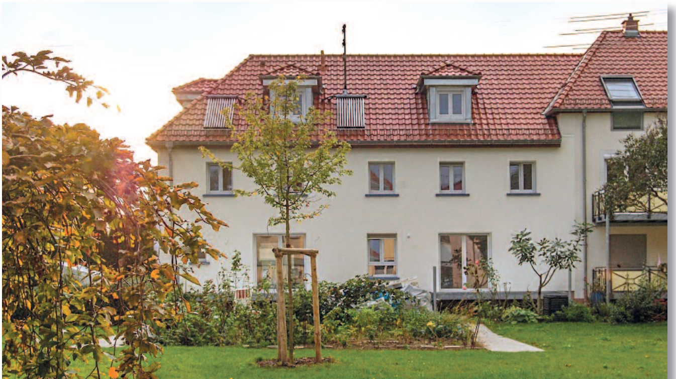
In der Kolmarer Straße 62/64 in Friedrichsfeld wurden zwei aneinandergrenzende Einfamilienhäuser aus dem Baujahr 1924 aufwendig mit Dachgeschossausbau kernsaniert. Zusätzlich wurde im Erdgeschoss ein Balkon geschaffen. Die Wohnflächen der 4-Zimmerhäuser liegen bei nun 132 qm bzw. 110 qm.
