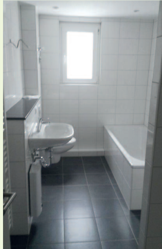
Mannheim Neckarstadt, Nürburgstraße 18, Badsanierung
