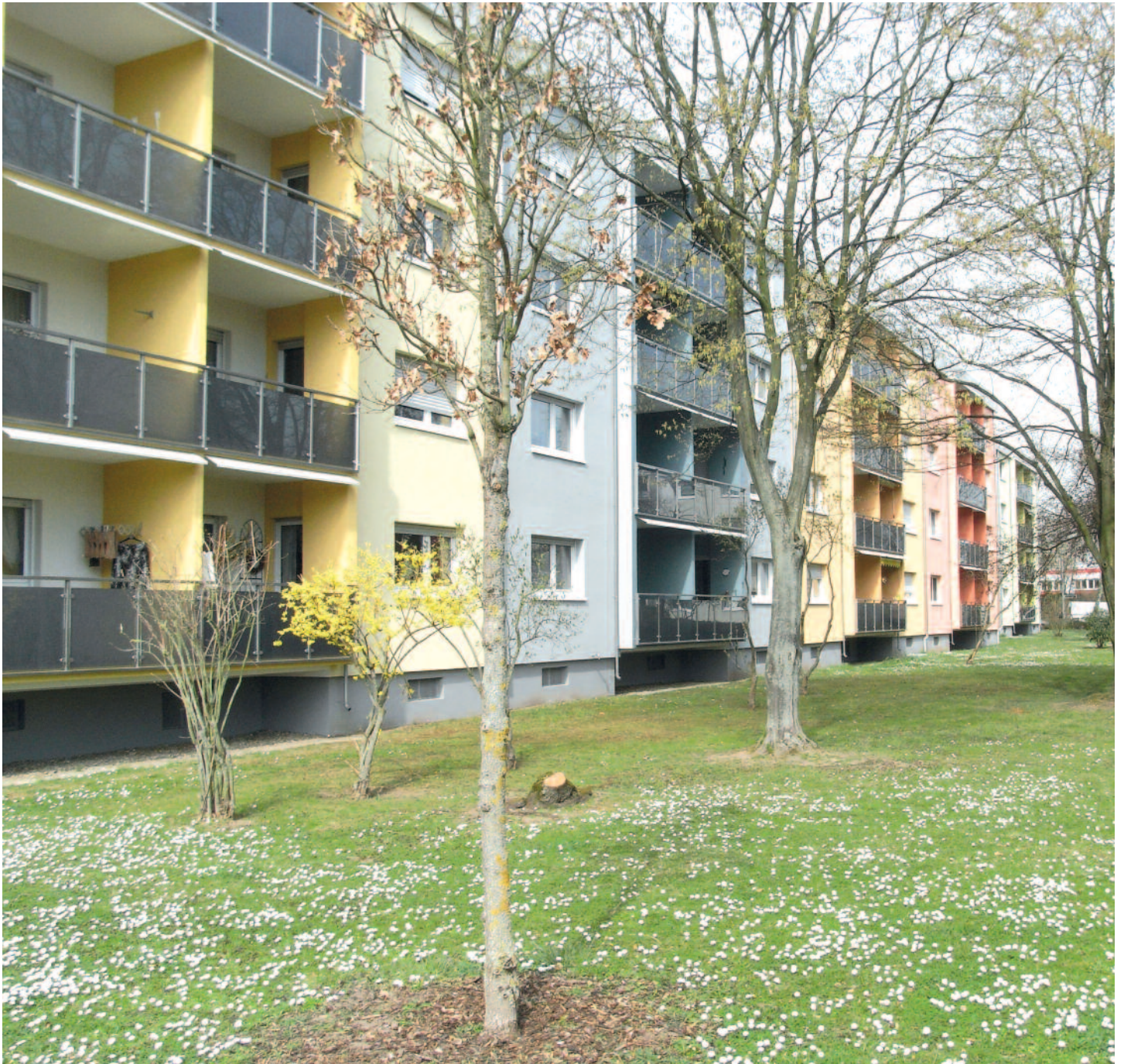
Mannheim Vogelstang, Zwickauer Weg 1-11 nach Balkonsanierung
